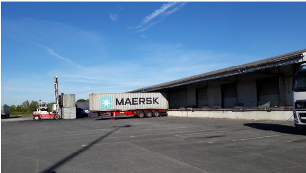
Bâtiment de stockage central
