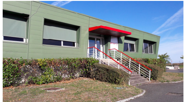
Bureaux / locaux sociaux
