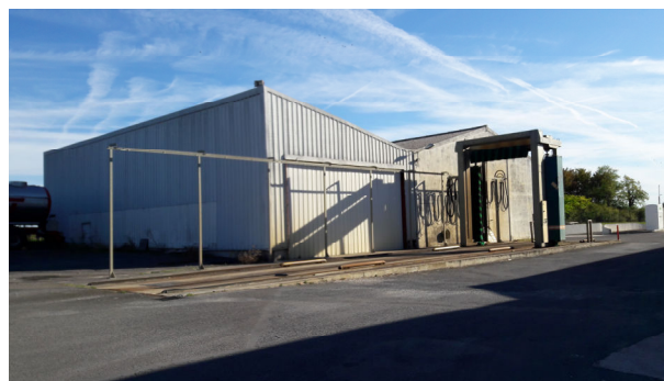
Station de lavage (situation actuelle)
